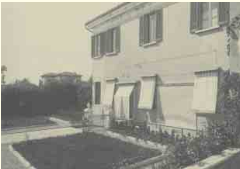
Edificio storico alla “Forca di Cane”
